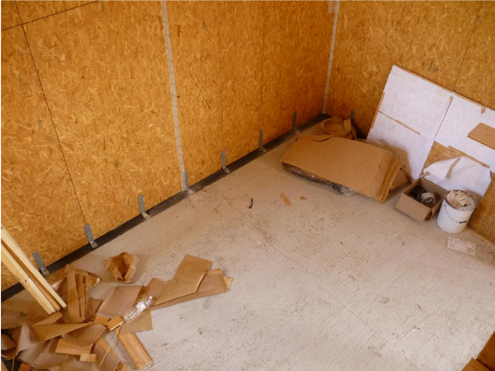
FISSAGGI DELLE PARETI
