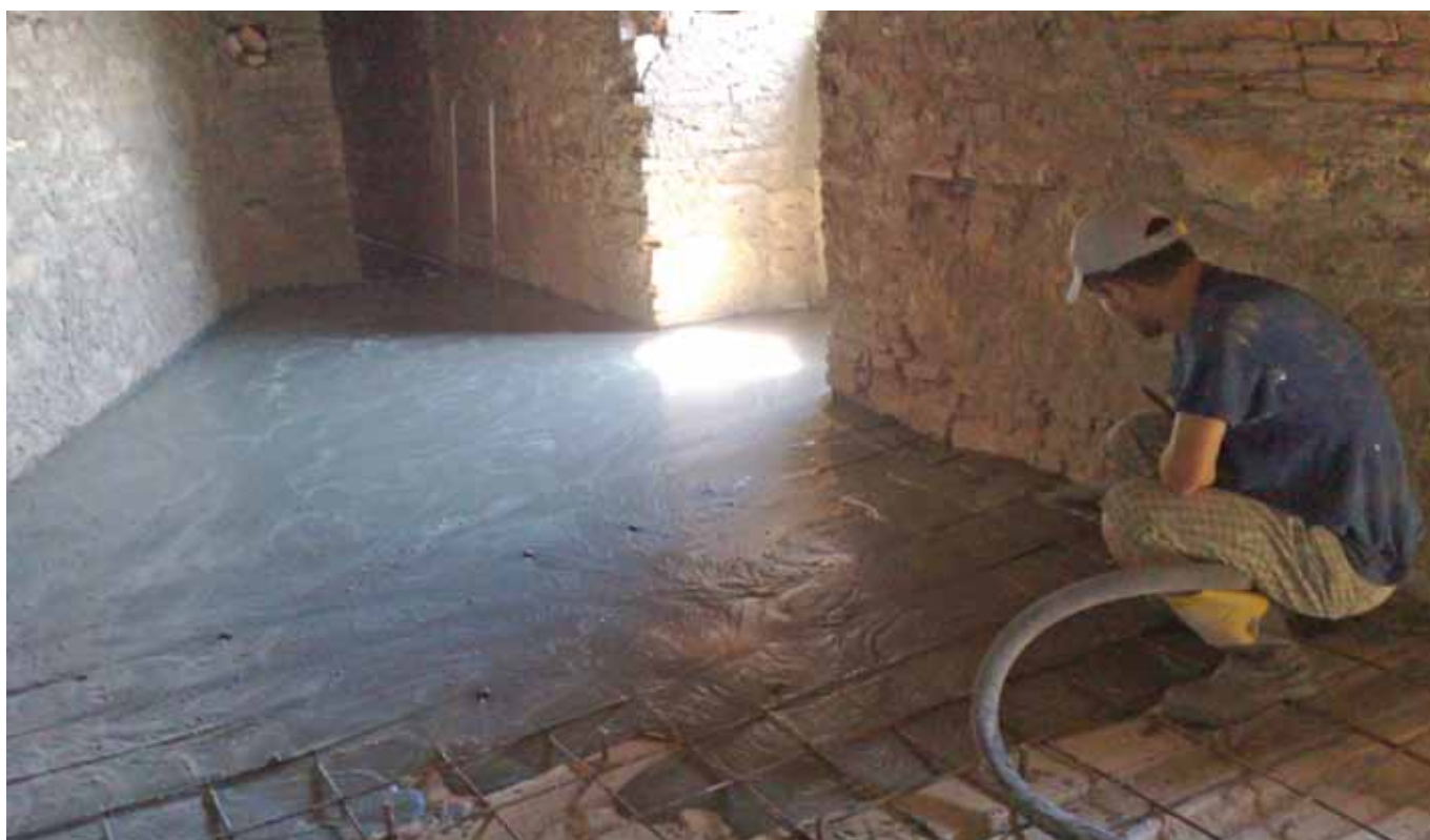
Progetto/luogo: rinforzamento del solaio nella chiesa a Castenedolo (IT) Gruppo prodotti/prodotto: Calcestruzzo standard/RÖFIX CreteoStandard CC 254 Pump
