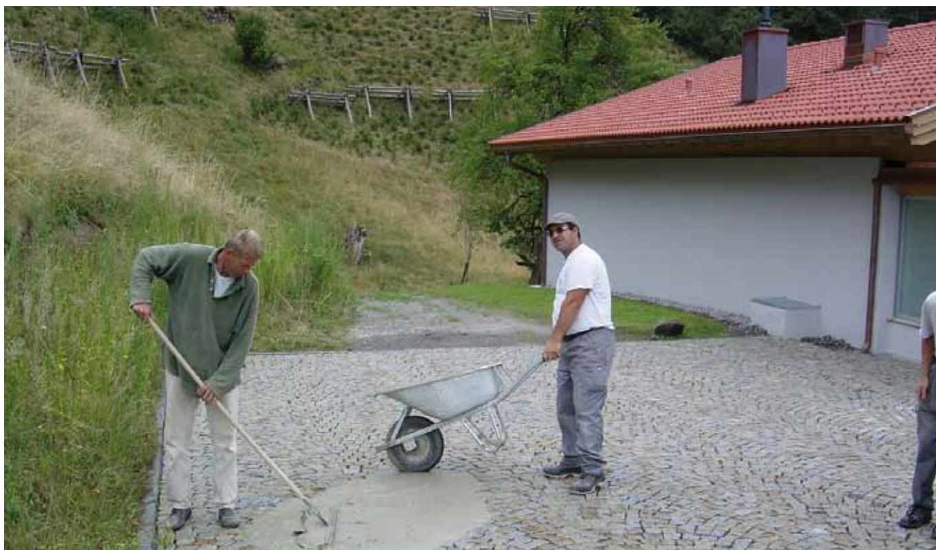
Progetto/luogo: sigillatura fughe in un lastricato a Klosterle (AT) Gruppo prodotti/prodotto: Sistemi di pavimentazione per esterno/RÖFIX CreteoGala 996
