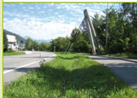
Fosso d'infiltrazione in zona industriale a Bressanone
