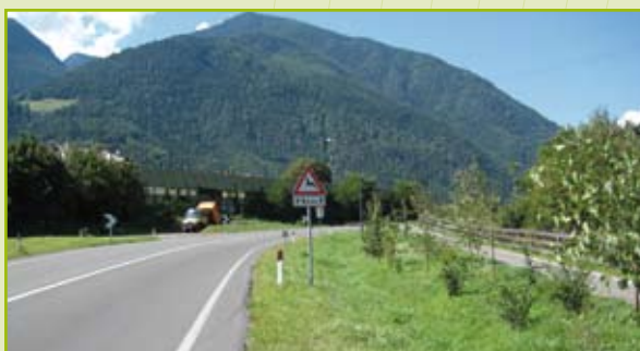
Fosso d'infiltrazione lungo via Brennero a Varna
