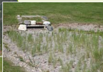
Depressione d'infiltrazione accanto al bacino di ritenzione
